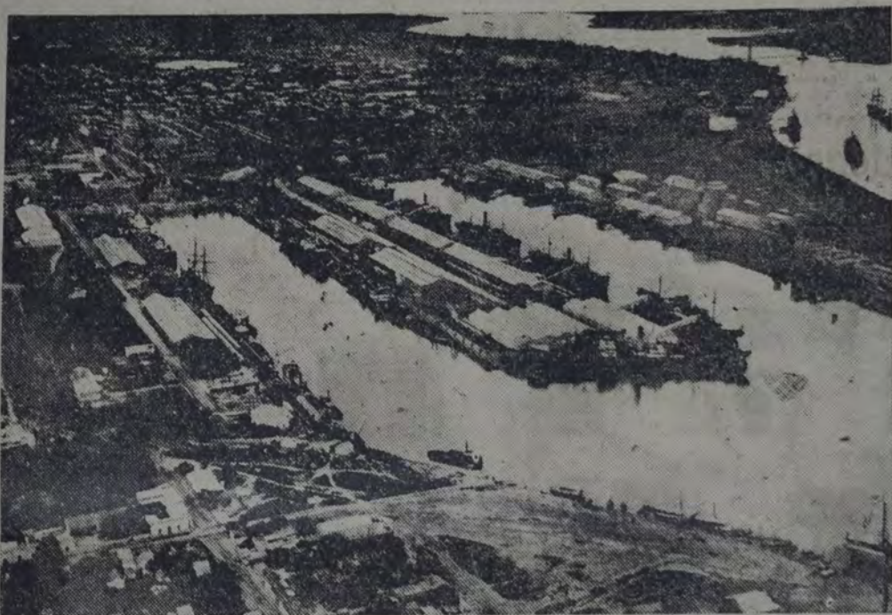
VISTA AEREA DEL PUERTO DE SANTA FE
